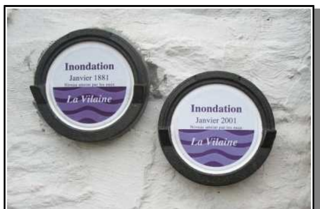
Illustration 7: Exemple de repères de crues (sur la Vilaine)
